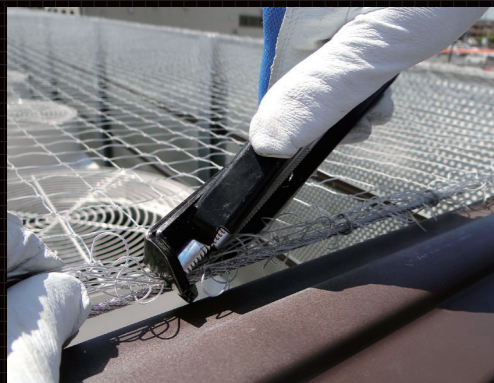
施工イメージ / ホグリング一留め
