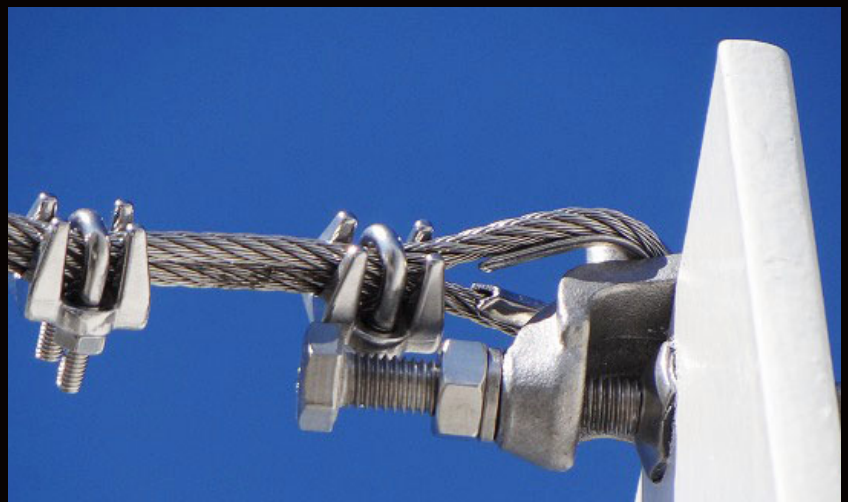
ワイヤークリップ [SUS ワイヤーφ4.0+ クランプ 37(H 型鋼用)+ ワイヤーコース]
