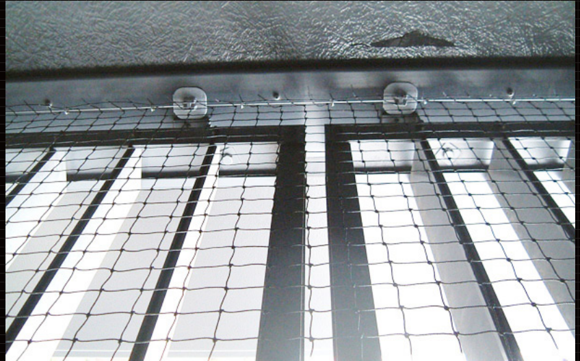
ABSプレート[トリカットネットスーパー+ホグリング+SUS ワイヤーφ2.0]
