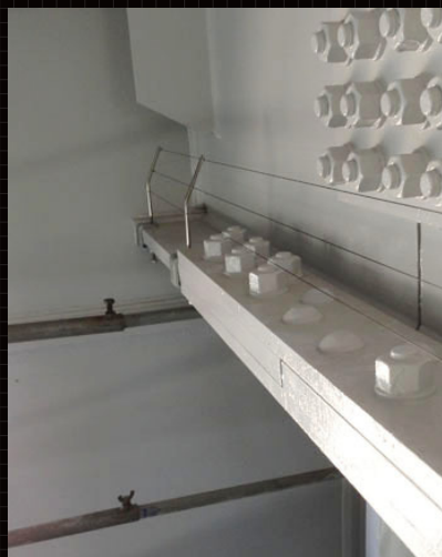
T 型ステイ くの字 3 段式・I 型ステイ [コーティングワイヤー φ0.81+クランプ金物]
