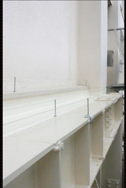
I 型ステイ・I 型ステイ+パイラック一体型 [SUS ワイヤー φ0.81]
