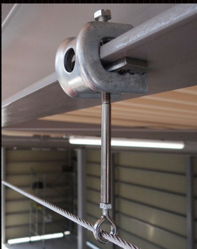
T 型ステイ [パイラック+ヒートンボルト+SUS ワイヤー φ20]
