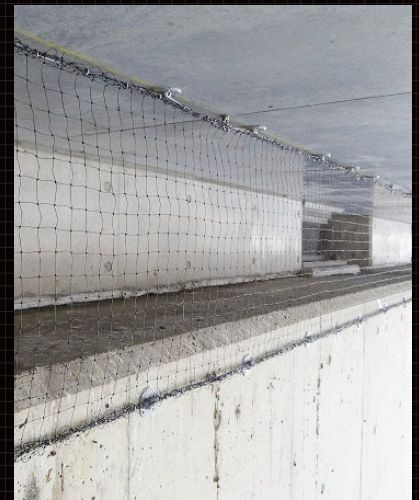
ABSプレート[トリカットネット+ホグリング+SUS ワイヤーφ2.0]
