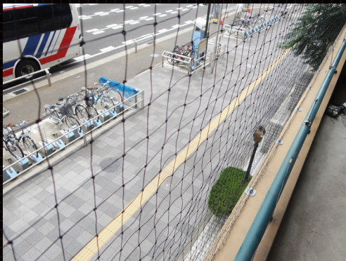
ABSプレート[トリカットネット+ホグリング+SUS ワイヤーφ2.0]
