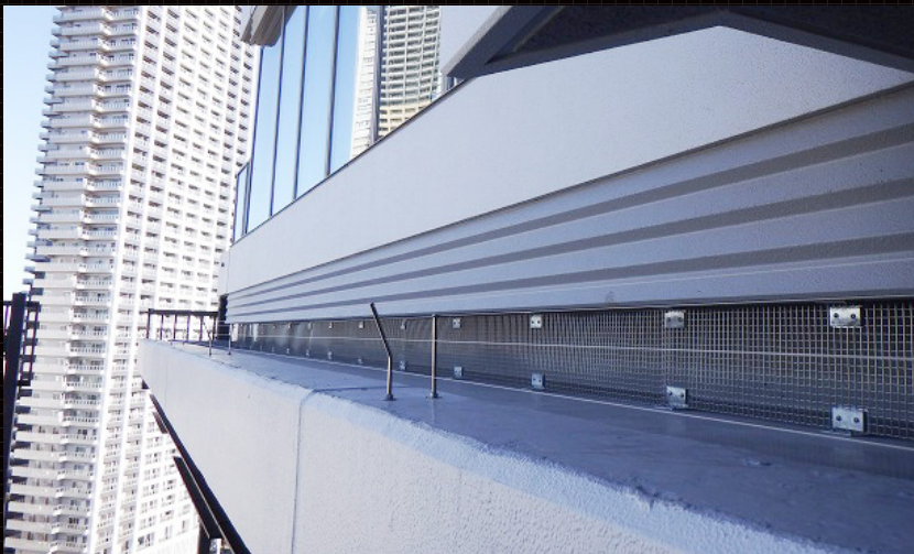
I 型ステイ くの字 3 段式・I 型ステイ [SUS ワイヤー φ0.81]
